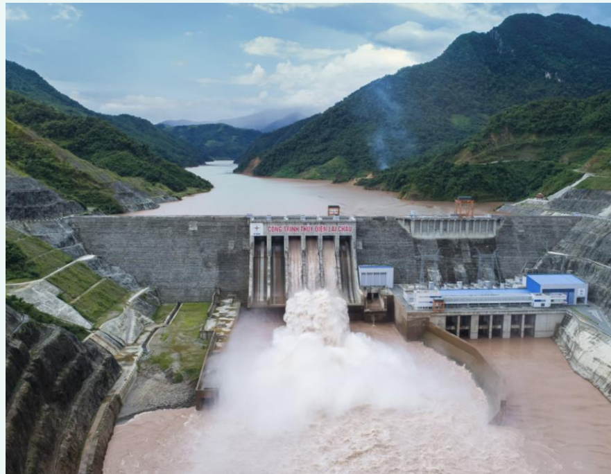
Nhà máy thủy điện Lai Châu (Lai Châu)
