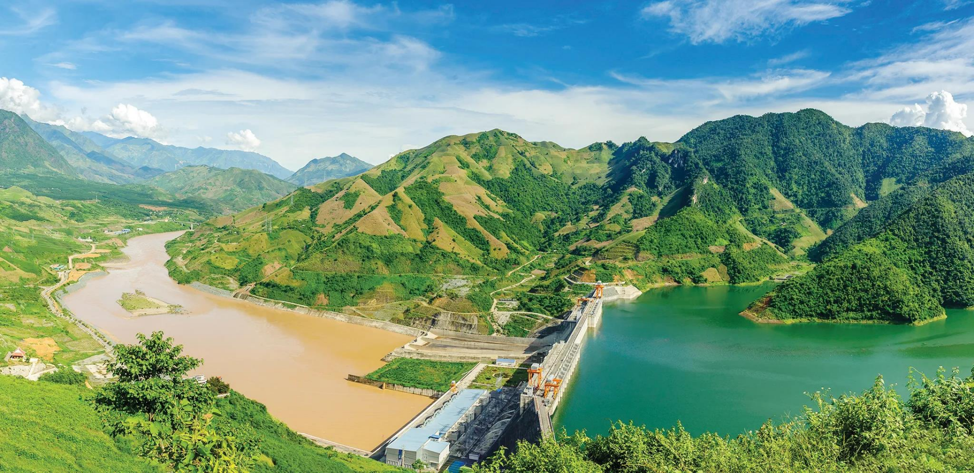
Nhà máy thủy điện Sơn La (Sơn La)
