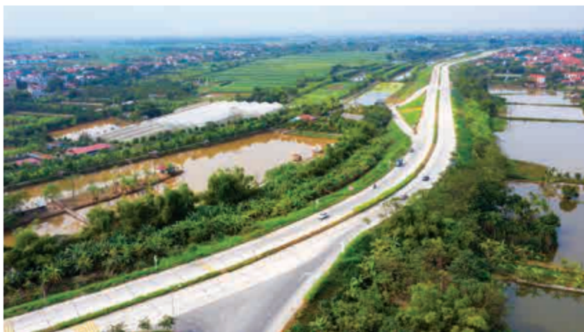
▲ Hình 5. Một đoạn đê sông Hồng
