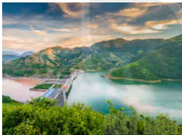
Hình 7.5. Đập thủy điện Sơn La trên Sông Đà
