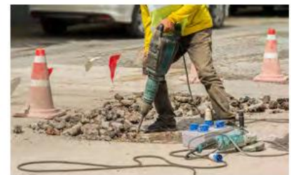
c) Máy khoan bê tông đang hoạt động
