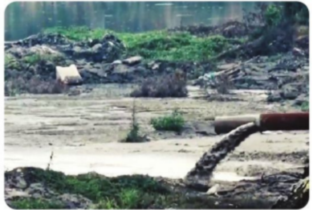
Hình 2. Nhà máy xả thải trái phép ra sông
