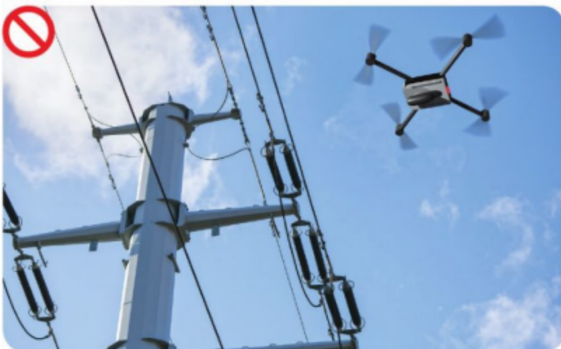
Hình 10.3. Vi phạm hành lang an toàn lưới điện cao áp
