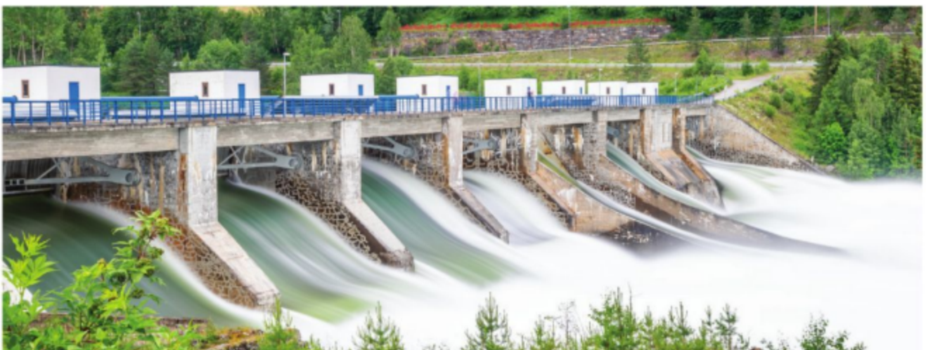
Hình 12.5. Nhà máy thủy điện
