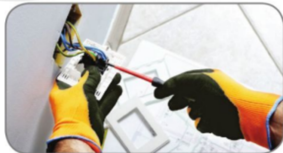
Hình 11.2. Sửa chữa mạch điện
