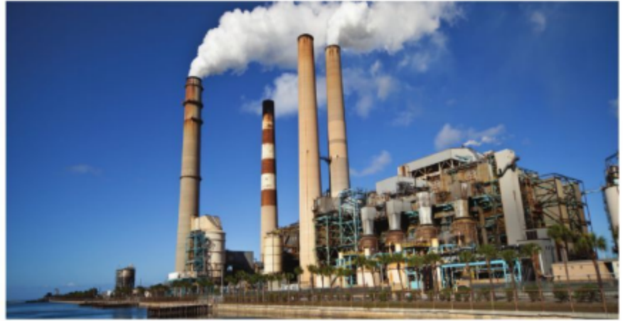
Hình 12.6. Nhà máy nhiệt điện
